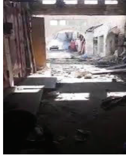
بعد احداث (2019م)
