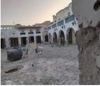
بعد احداث (2019م)
