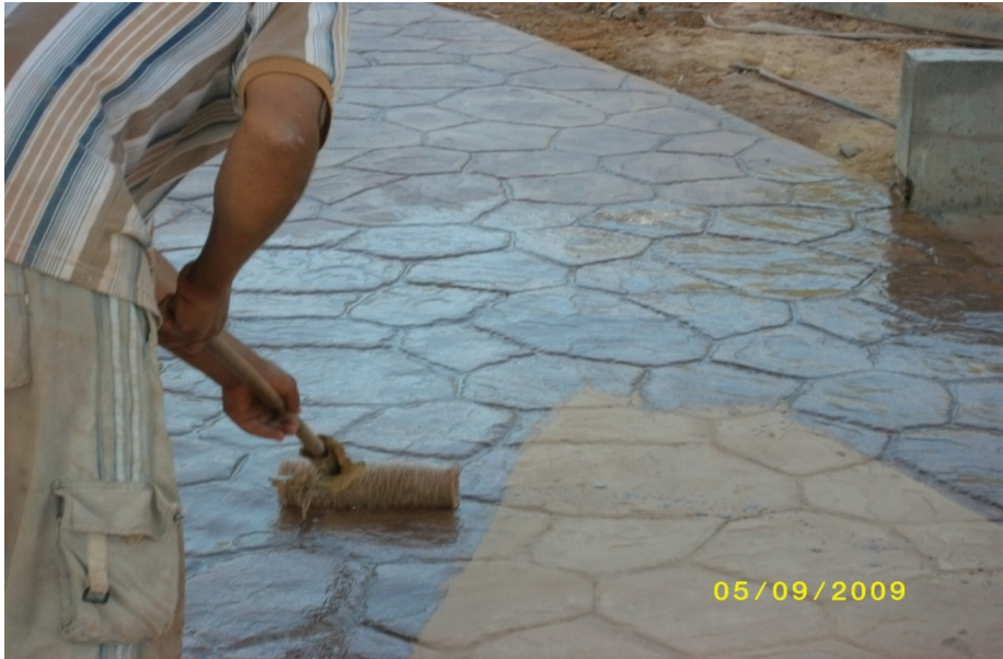
شكل رقم 11 : يوضح وضع طبقة لامعة
