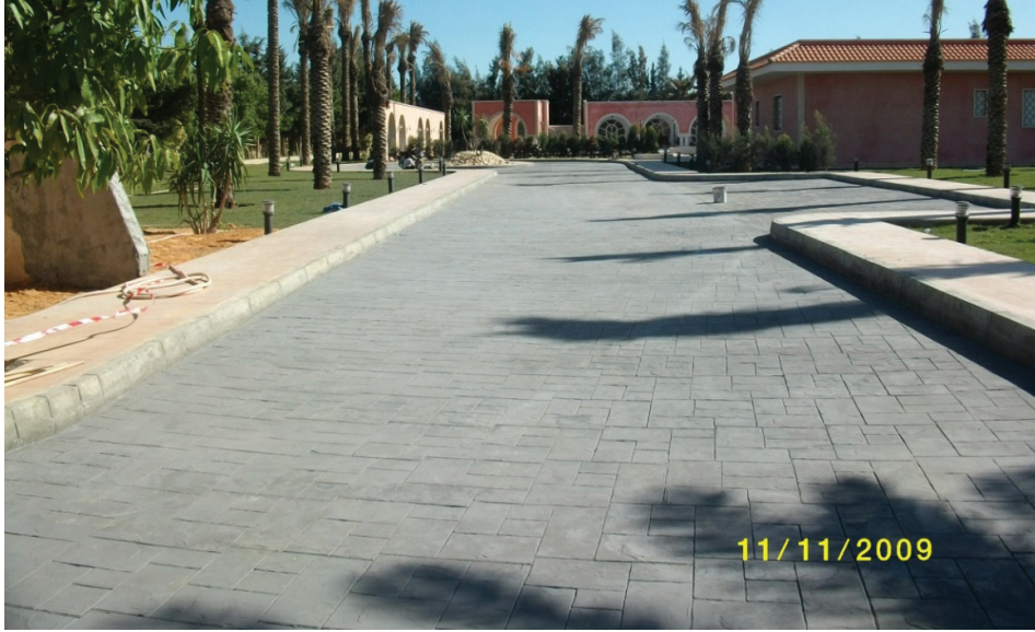
شكل رقم 10 : يوضح الطباعة
